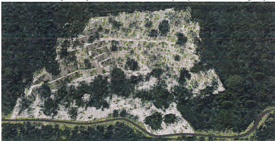
EP Mrkovac- simulacija središnje faze tehničko-biološke sanacije, s djelomično izraslom vegetacijom
